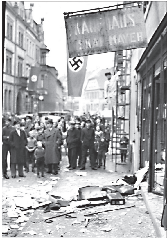
Bahnhofstraße, Kaufhaus Mayer (Quelle: Heimatmuseum)
